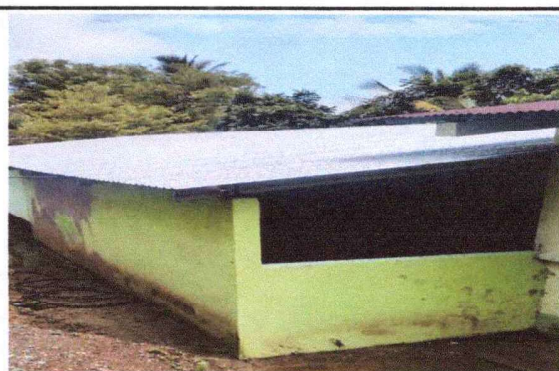
Foto 4: Terminando de Pintar las paredes de Remozamiento de la Aldea Chiacach
