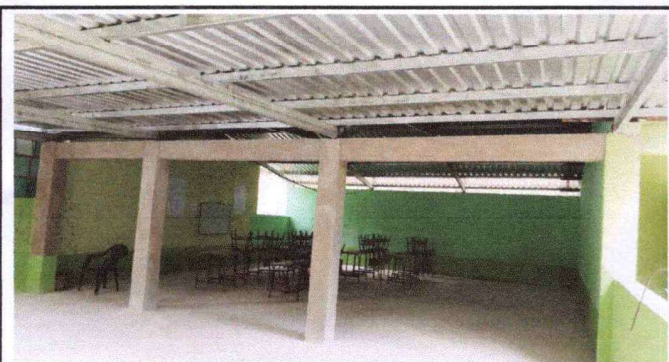
Foto 3: Termination de Piso concreto del Proyecto de Remozamiento de la EORM Aldea Chiacach.
